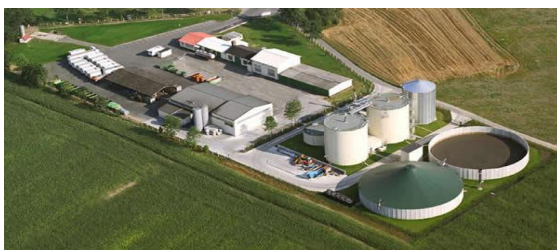
Tratamiento de aguas
