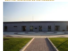
FOTO DEL EDIFICIO DE LABORATORIOS ESPECIALES "ELE" CENAM. MÉXICO.
